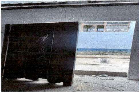
Foto 3: 4.3 Sustrucción de Puerta
