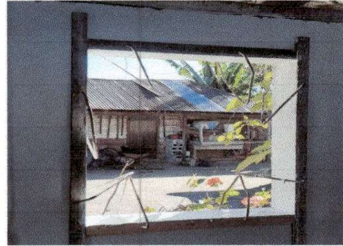
Foto 4: 5.3 Sustrucción de ventana
