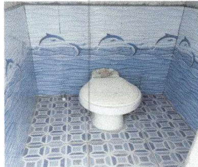
Foto 10: 10.3 Sustitución de inodoro
