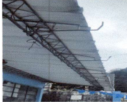
Foto 8: 7.2 Sustitución de canal de PVC
